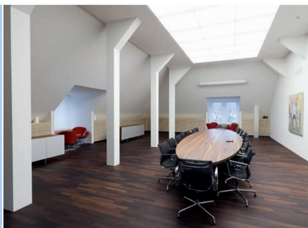
Quelluftauslass mit Holzverkleidung.
