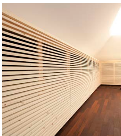
Quelluftauslass mit Holzverkleidung.
